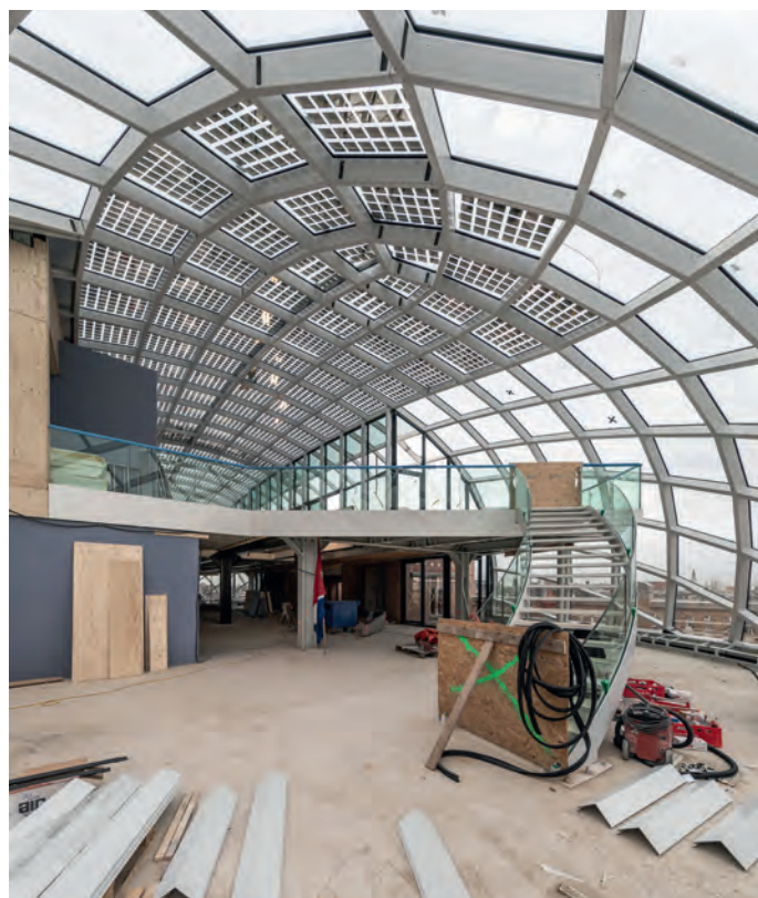
De tweelaagse dome met ingebouwde PV-cellen in het dak.
